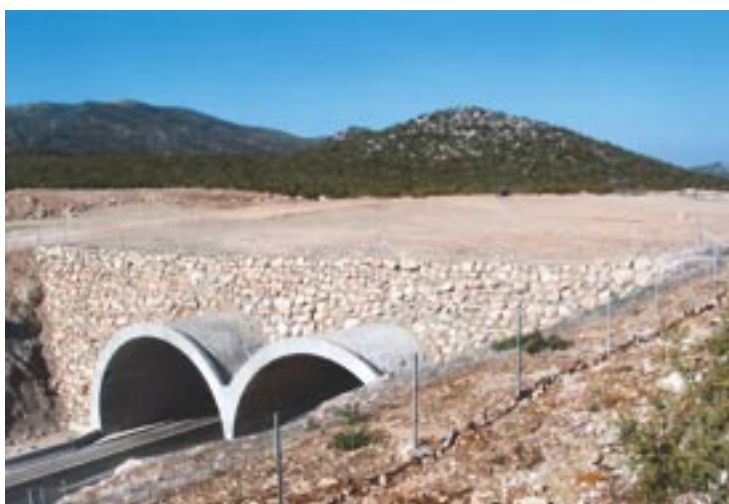
Slika 40. Zeleni most Osmanovac na autocesti Zagreb - Split – dionica Prgomet - Dugopolje izgrađen je upravo zbog prisutnosti vukova (J. Kusak)
